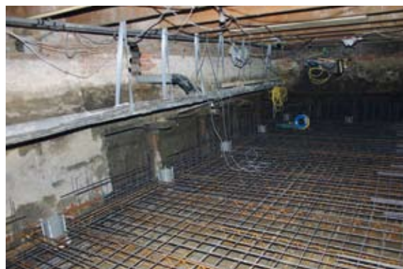
Onderkeldering in combinatie met VDM-vijzelpalen
