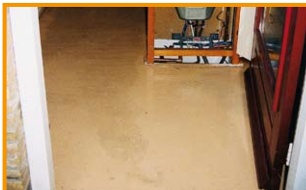
Afgewerkte deklaag
