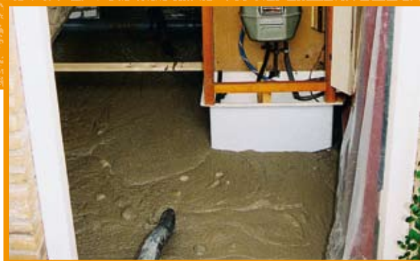
Aanbrengen Belbeton®
